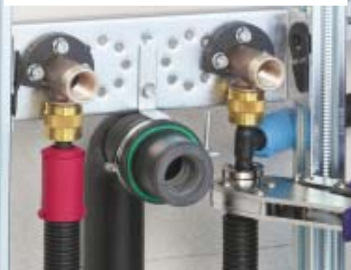
Geberit Mepla Rohr aufschieben, verpressen
