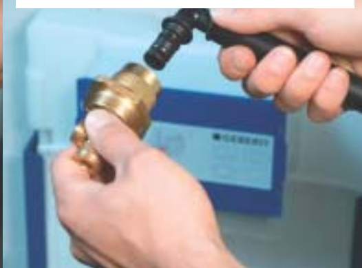
PVDF-Fitting mit verpresstem Rohr einstecken: „Klick“
