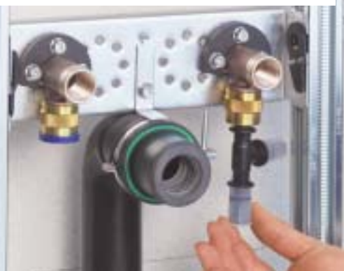
PVDF-Fitting bis zum „Klick“ einstecken
