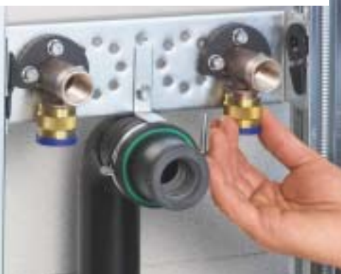
Geberit MeplaFix Steckadapter bis auf Anschlag aufschrauben
